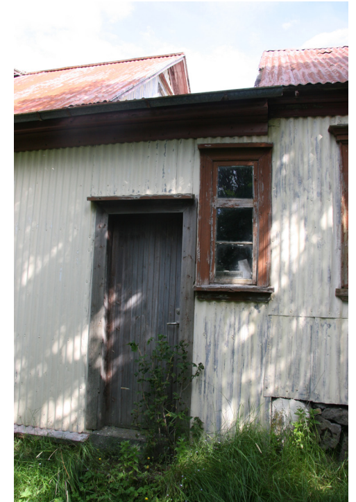
Tengibygging milli húsluta frá 1898 og 1927. Gluggi hefur verið settur við hlið dyranna. Í honum eru enn upphaflegir rammar. Upphafleg útidyrhurð stendur í forstofunni.
