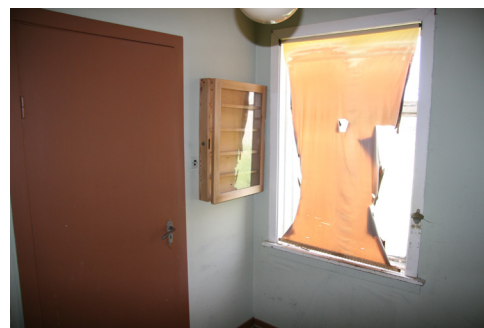
Herbergi í norðvesturhorni neðri hæðar þar sem lúgsala var undir lok veitingasölu tímabils Múlakots.
