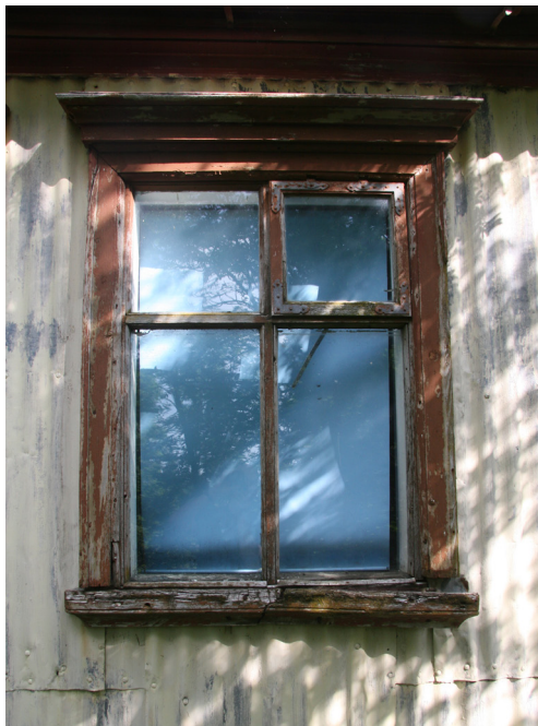
Gluggi húss frá 1898. Umbúnaður líklega upphaflegur en glugginn hefur verið stækkaður. Póstaskipan upphafleg en ramar hafa verið fjarlægðir.
