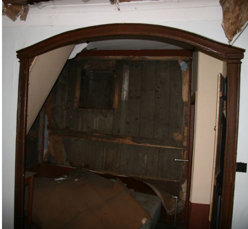
Norðurveggur einkastofu með þiljum sem gerðar eru úr endurnýttum borðum.
