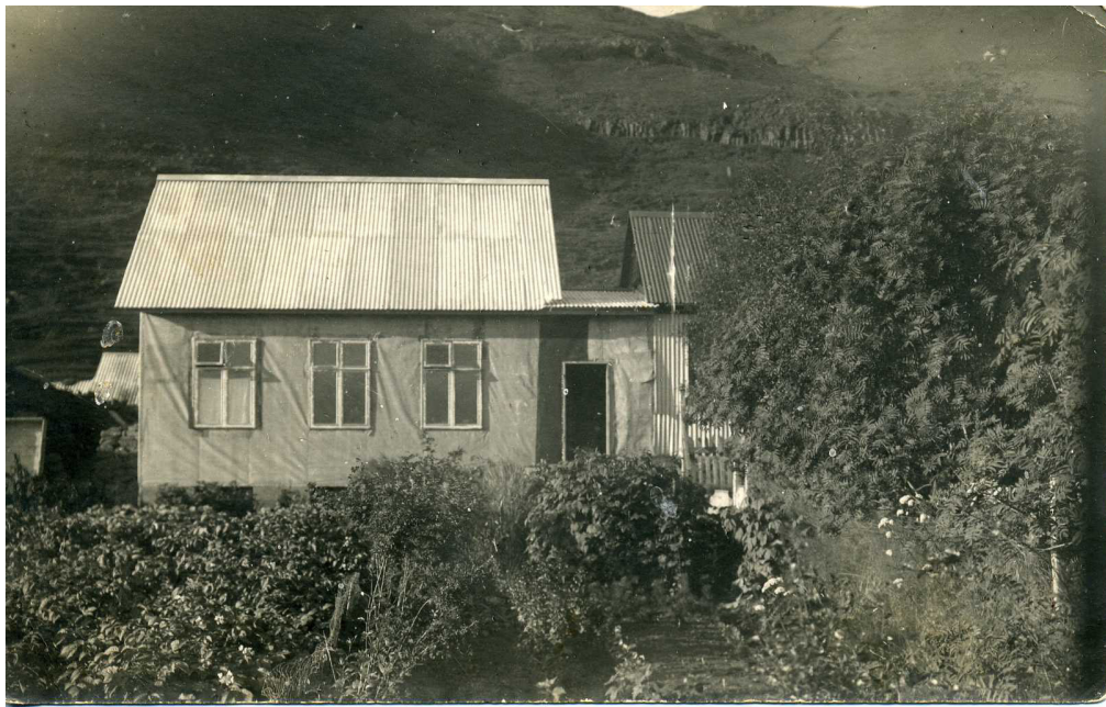
Viðbyggingin frá 1927. Smíði hússins er ekki að fullu lokið. Bárújárn hefur ekki verið sett á vegg þegar myndir var tekin. Einnig vantar gluggaumgjörð. Bíslagið frá 1898 er orðið að tengibyggingu og þaki þess hefur verið breytt. Ljósm. í eigu Sigríðar Hjartar.
